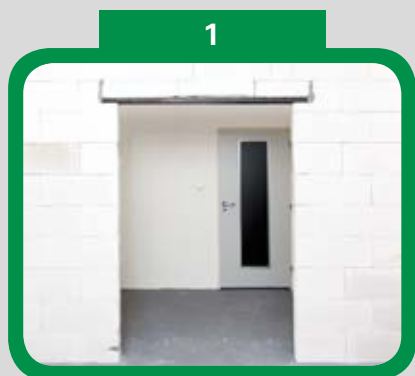
Připravený stavební otvor
