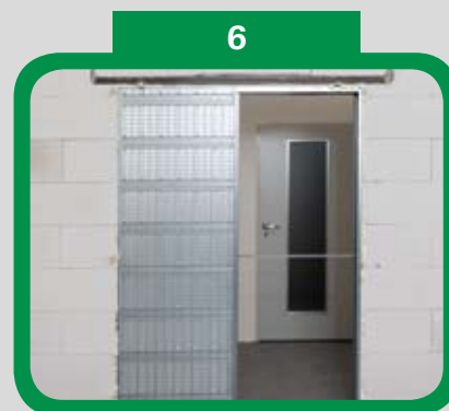
Zapěněné pouzdro ve stavebním otvoru
