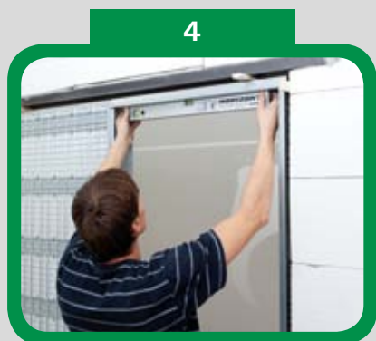
Vyvažte stavební pouzdro horizontálně a vertikálně
