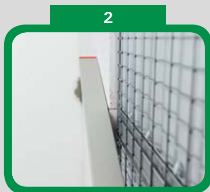
Vložte stavební pouzdro do stavebního otvoru
