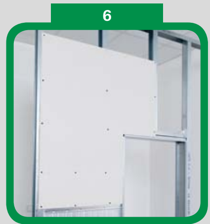
6 Usazené a zabudované pouzdro
