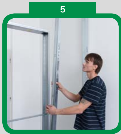
5 Montáž protilehlé strany SDK konstrukce
