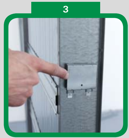
3 Kotevní místo pro SDK profil stavebního pouzdra
