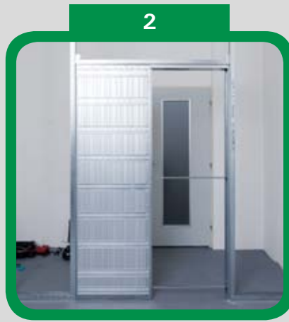
2 Usazení pouzdra do spodního profilu SDK
